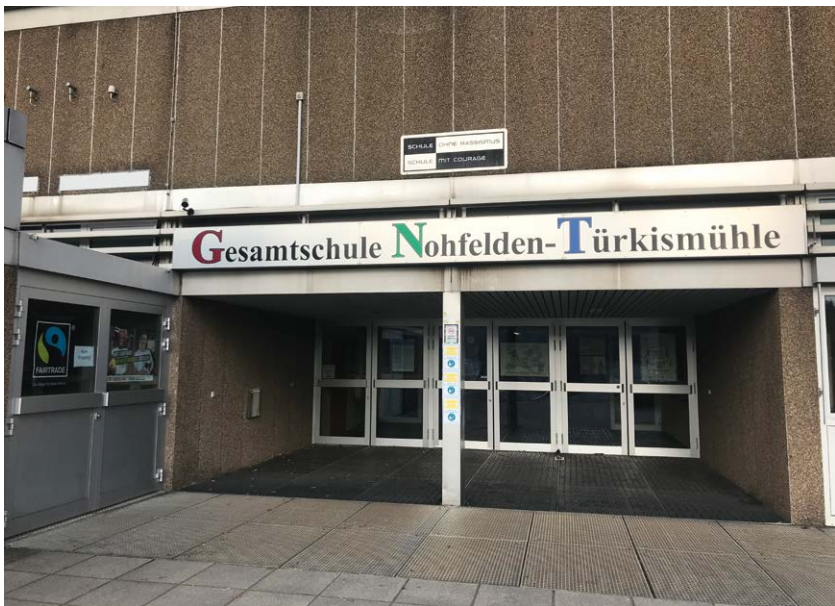
Abb. 25: Eingangsbereich der Gesamtschule Nohfelden-Türkismühle
