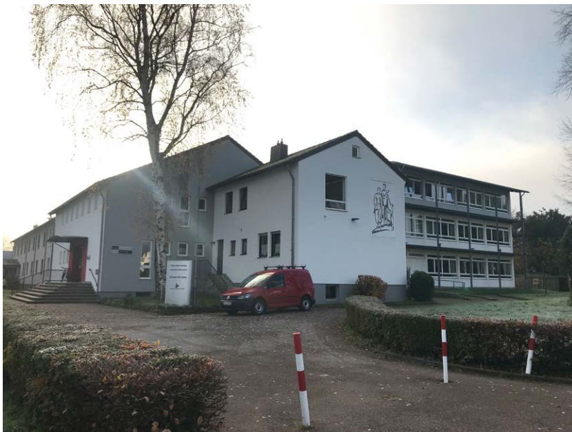
Abb. 36: Eingangsbereich und Hauptgebäude der Lothar-Kahn-Schule Rehlingen
